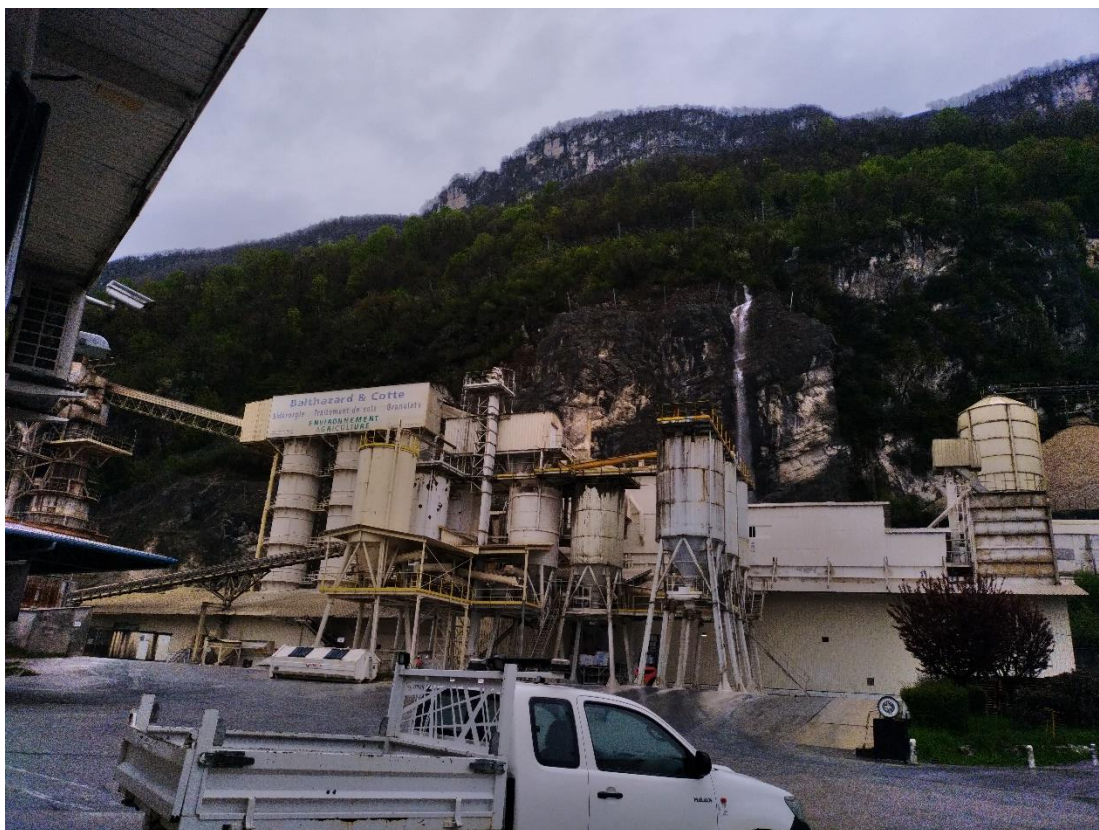
Figure 2 : Unités de criblage/ broyage/ concassage et fours au charbon verticaux
