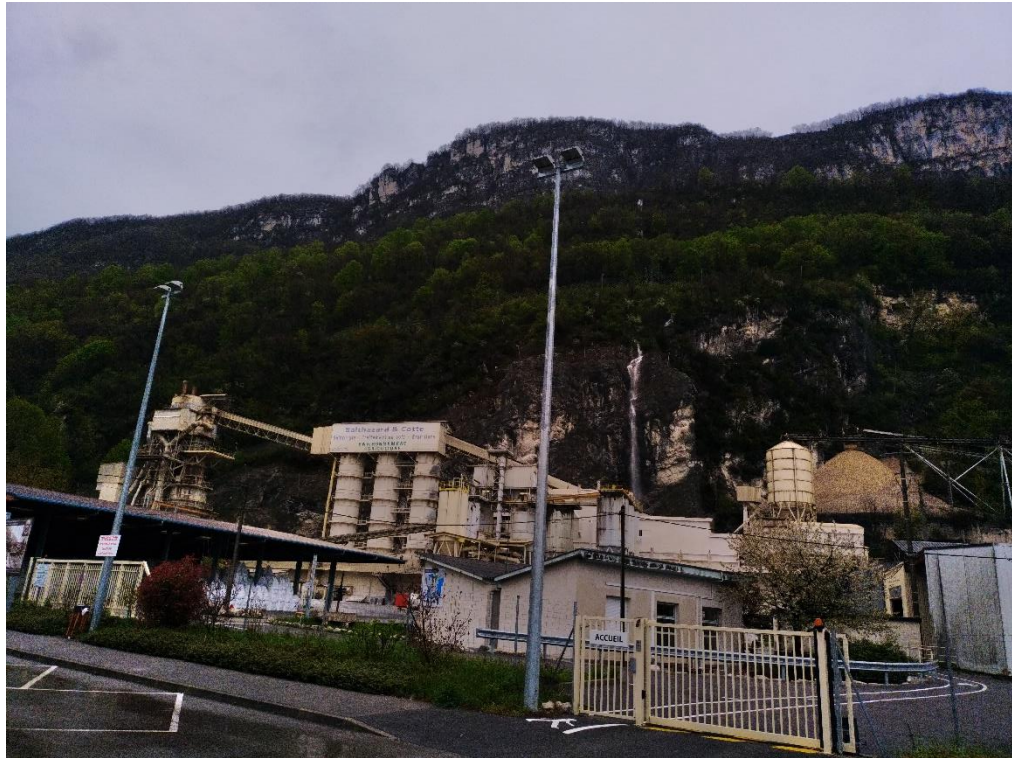
Figure 1 : Vue générale du site
