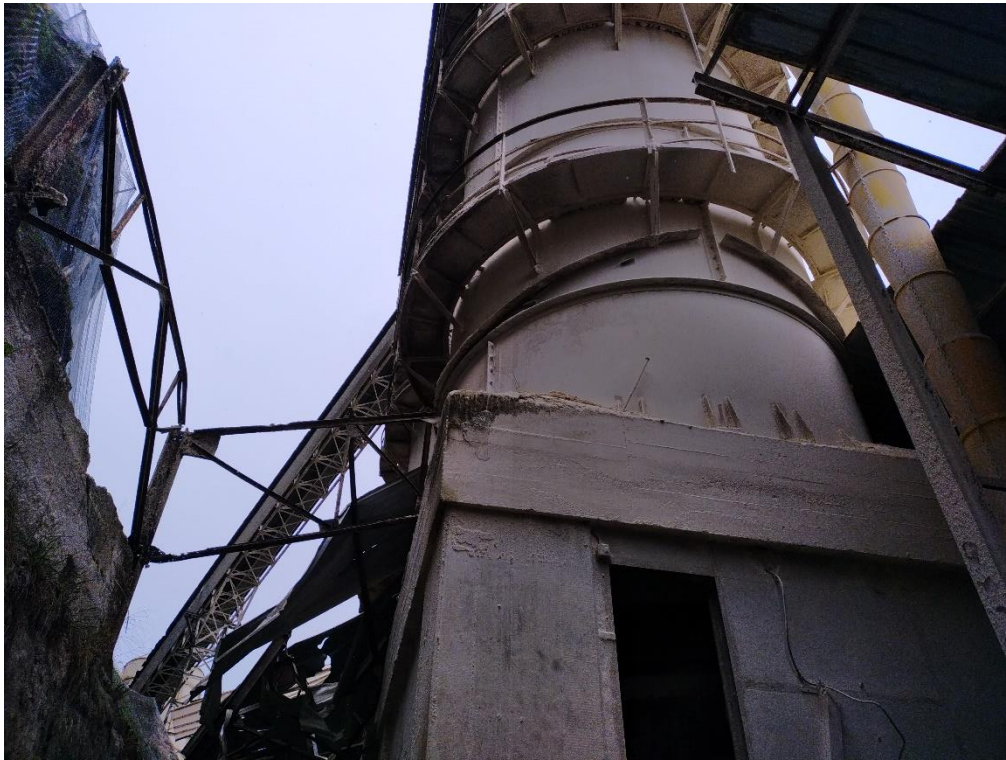
Figure 17 : Anciens four verticaux à charbon
