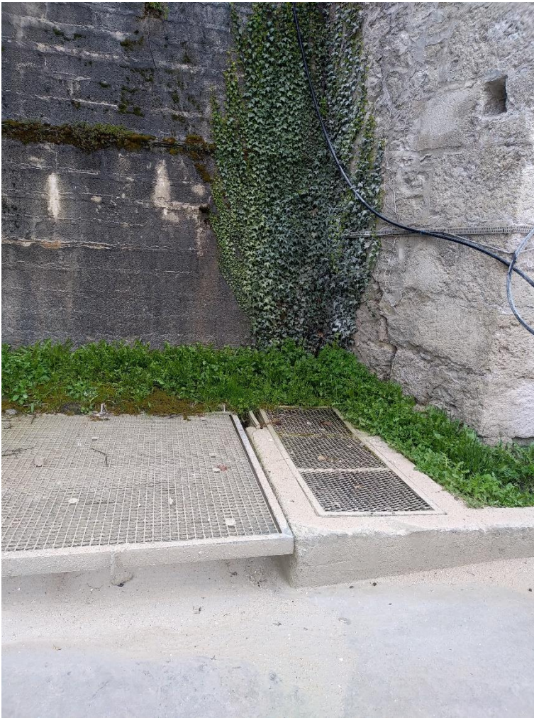
Figure 28 : Déshuileur zone lavage engins chantier
